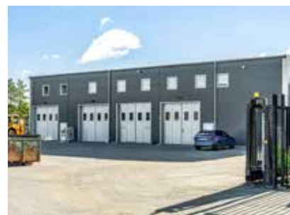
Industrifastighet med 4 lokaler - NACKA
