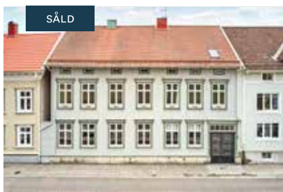
Bostadsfastighet - VÄNERSBORG ANSVARIG: per-anders.haglund@bjurfors.se
